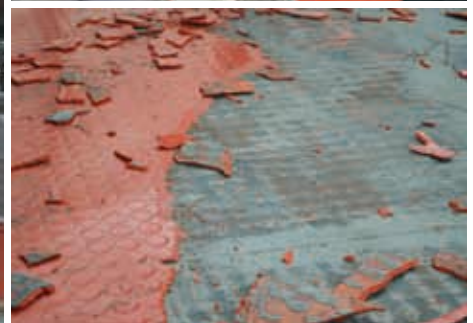
Baustellenbesuch 2: Das Stadttor Düsseldorf ist ein Prestige-Objekt. Hier soll die Empfangsebene erneuert werden. Der alte Nora-Kautschukboden ist in die Jahre gekommen und soll durch einen neuen ersetzt werden. Zehn Bauabschnitte sind hierfür vorgesehen. Das Problem: Der Altbelag lässt sich kaum entfernen. Belag, Klebstoff und Untergrund sind aufgrund von Sonneneinstrahlung eine nahezu unzertrennliche Beziehung eingegangen. Zudem ist der Belag porös und brüchig geworden, was »Stückchen-Arbeit« bei der Abtragung bedeutet.
